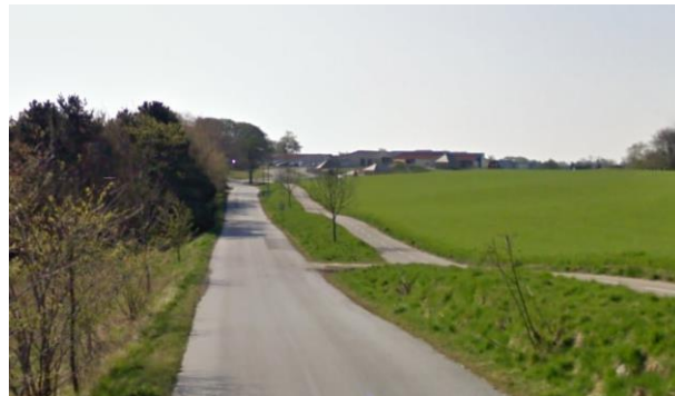
Figur 36. Dobbeltrettet cykelsti langs Schiwesvej set mod Græsted i sydøstlig retning (Google Maps).
